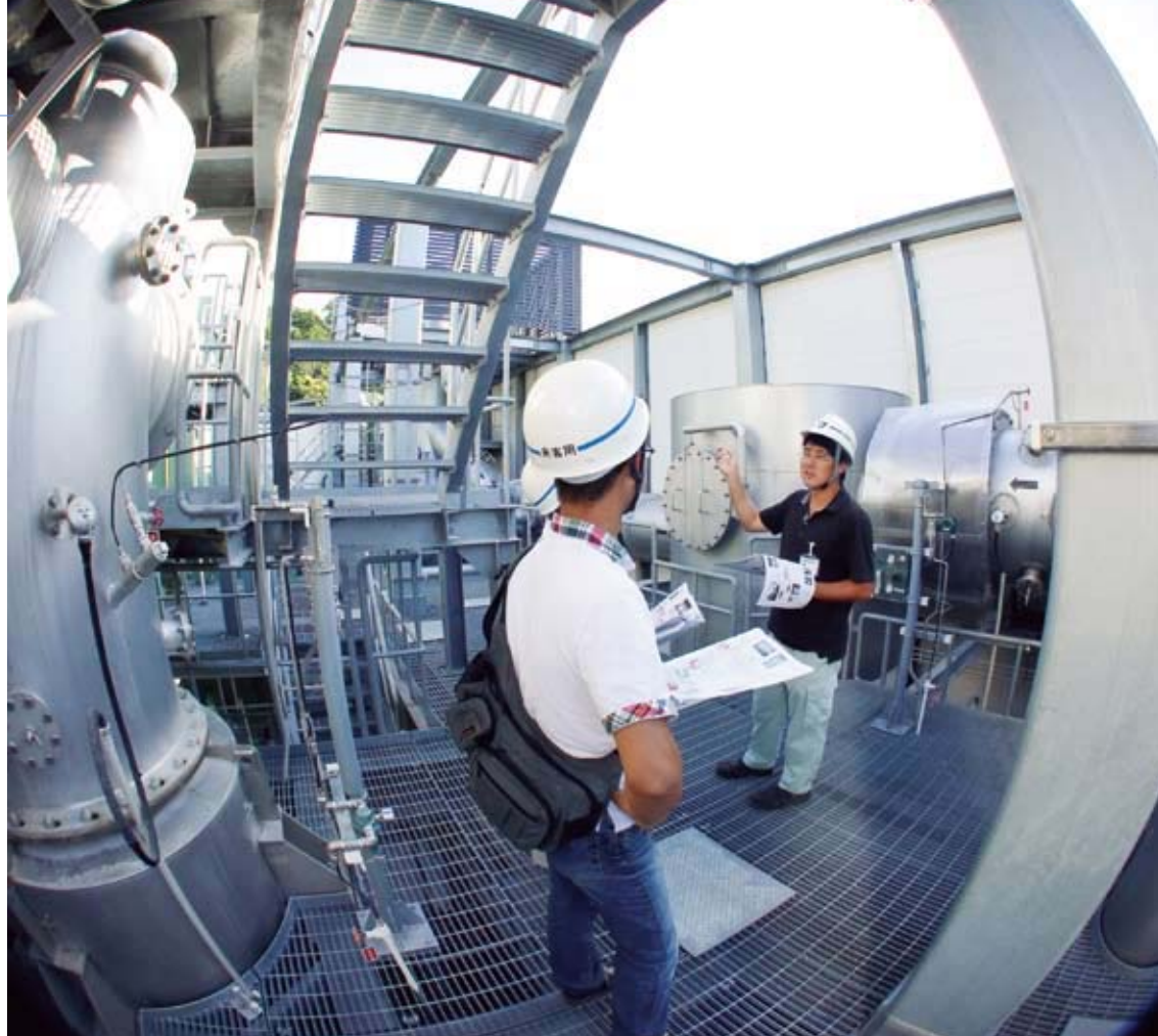
「下水道きれいな湖国の第一歩」汚泥焼却溶融設備
